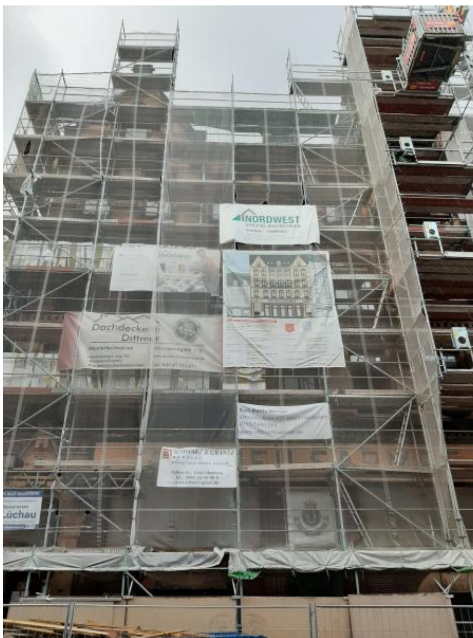
Die Arbeiten am
